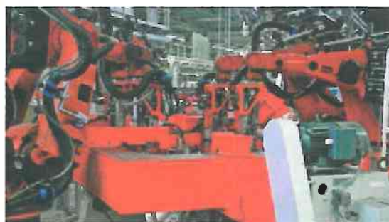
Schraubroboter mit den stabilen, mehrdimensional beweglich Energiezuführungen laufen komplikationslos.
